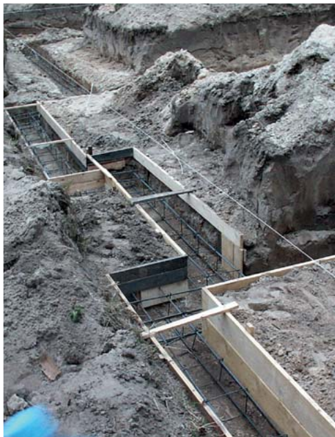
Pierwszy etap prac – budowa fundamentu.
