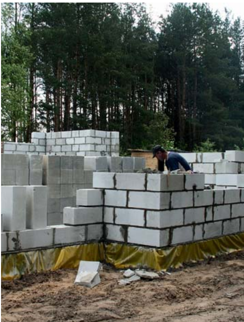
Ściany zewnętrzne zostały wzniesione z betonu komórkowego.
