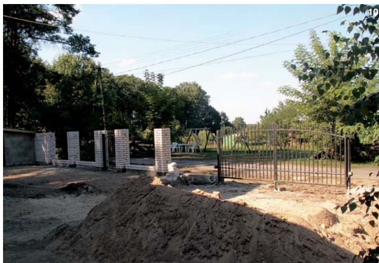
Ogrodzenie wykonane jest z cegły oraz ręcznie kutych elementów stalowych.
