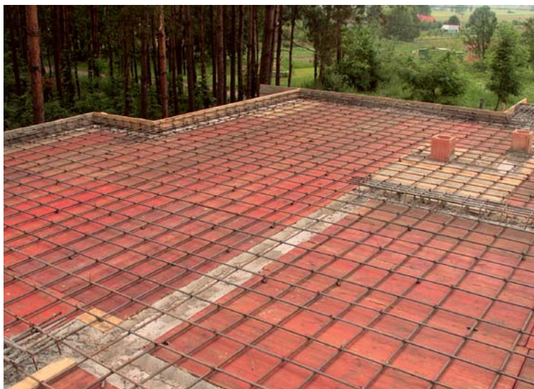
Zbrojenie stropu.
