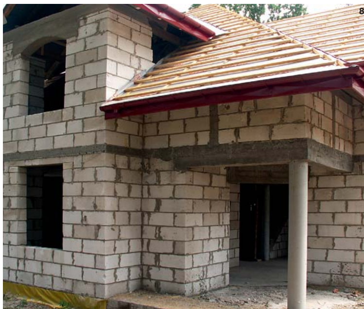
Dach został pokryty blachodachówką w kolorze czerwonym.
