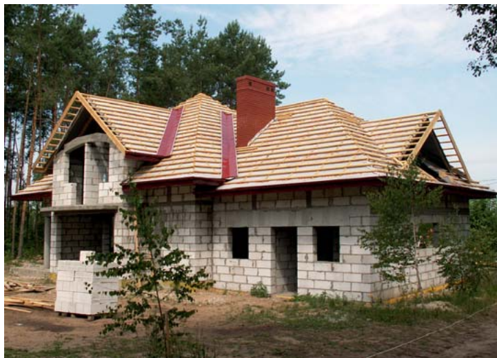
Zamontowane zostało orynnowanie. Dach jest gotowy na położenie pokrycia.
