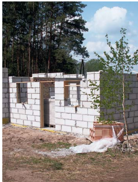
Ściany parteru są już praktycznie gotowe.
