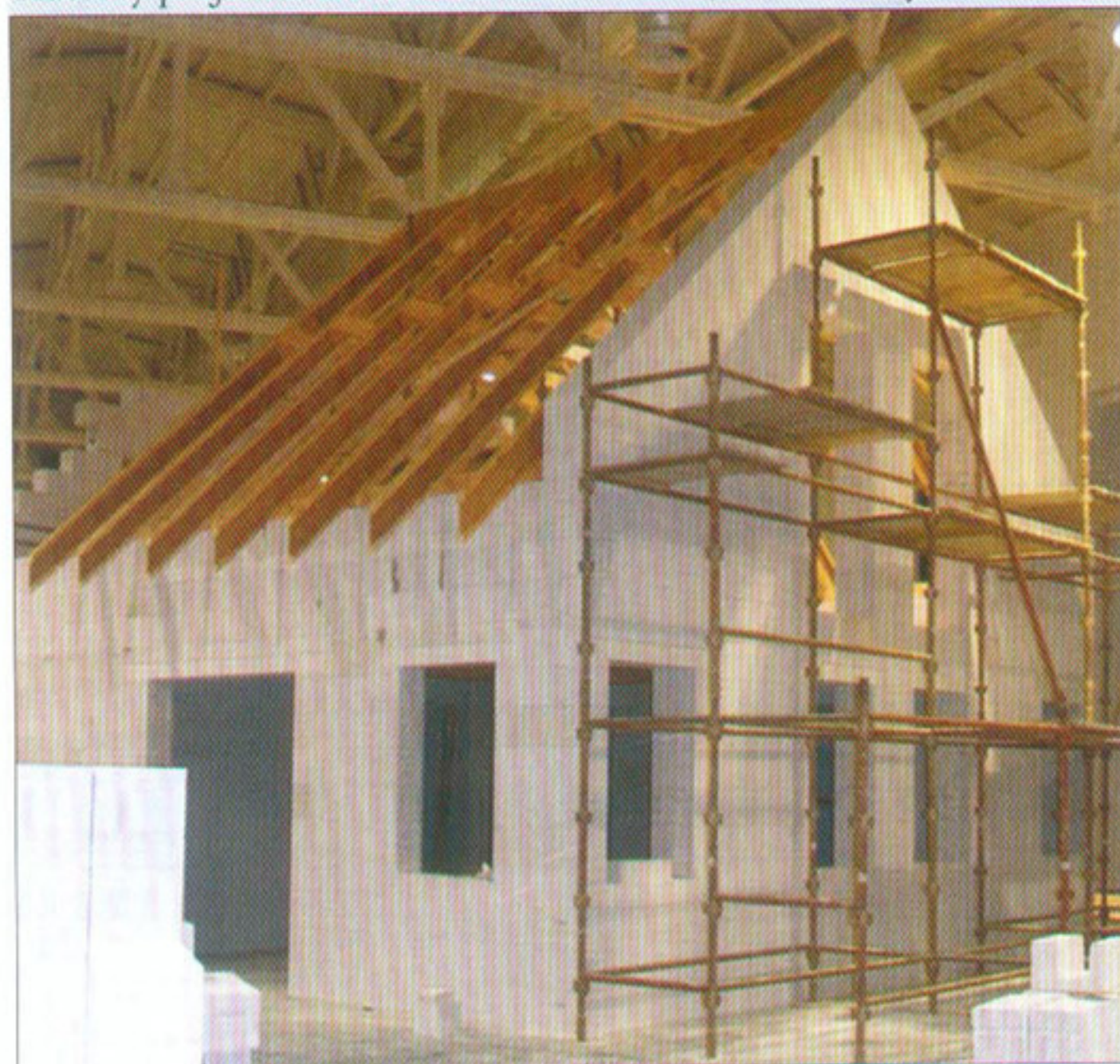
Jeden z etapów budowy Magnolii na BudShow
